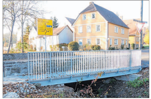
Damit die Fußgänger, auch die Schüler, sich die Steinbrücke in Gollhofen nicht mehr mit den Autos teilen müssen, entstand jetzt ein eigener Steg für sie.
